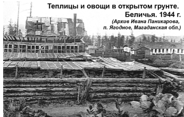
Теплицы и овощи в открытом грунте.
